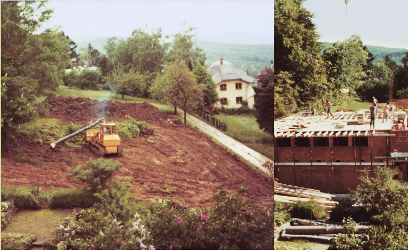
Das neue Schulgebäude entsteht 1978
